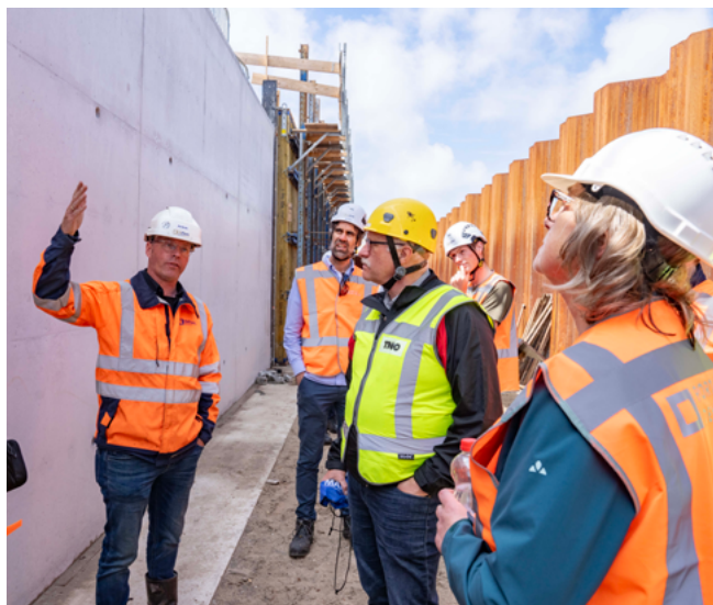
Antoin Veen, uitvoerder De Klerk, geeft uitleg over de renovatie Kade Het Nieuwe Werk.
