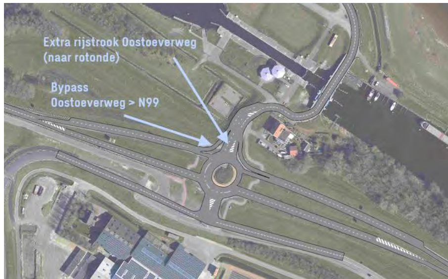
Figuur 44: De doorgevoerde maatregelen op de rotonde Oostoeverweg – N99
