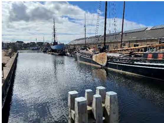
Figuur 10. Zicht op de reparatiekade.
