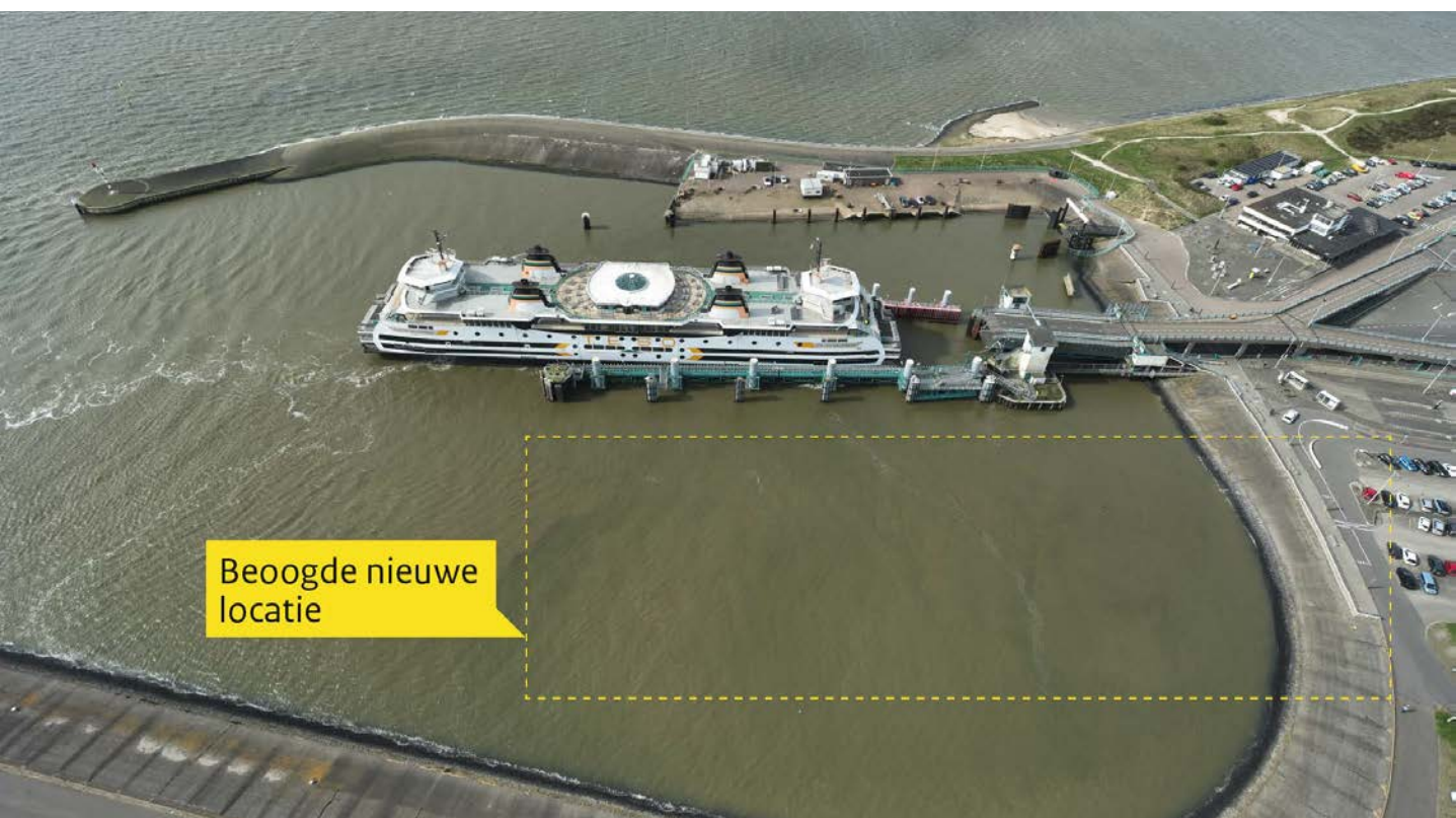
Op Texel komt de nieuwe aanlandinrichting zeer waarschijnlijk naast de bestaande te liggen.
